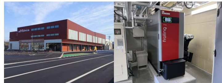
複合商業施設 ウッドリーム チップボイラー 180kW R5.9.1稼働開始
