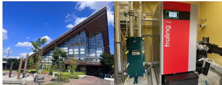
木材工芸館 キノス チップボイラー 150kW R5.3.17稼働開始
